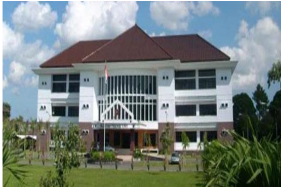
Gambar 2. Gedung KPLT Tampak Depan
