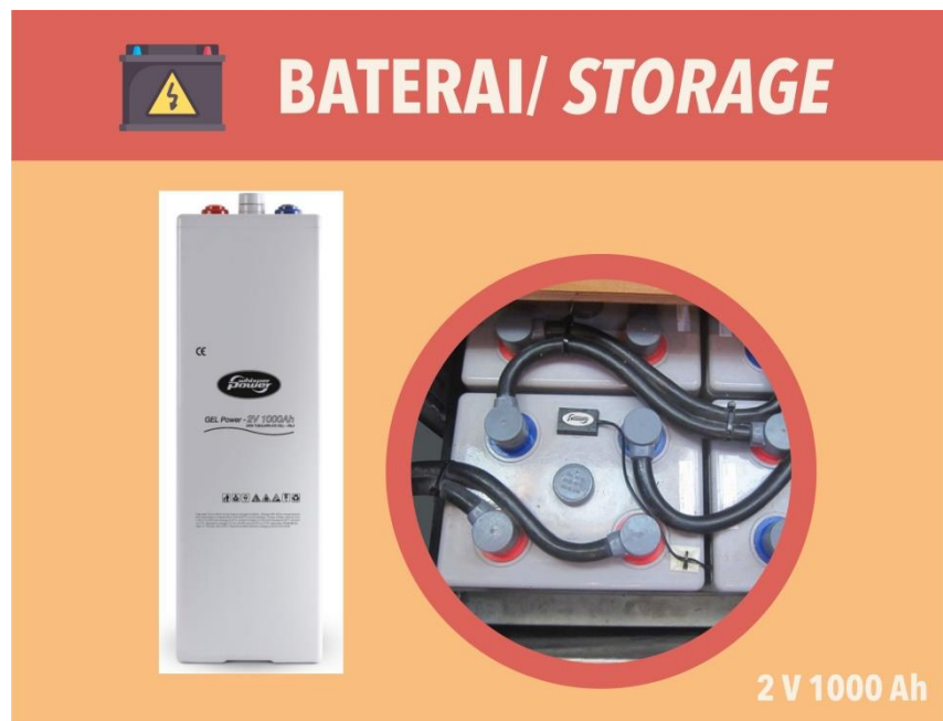
Gambar 17. Baterai pada Storage Room
