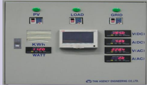
b. Meter dan Indikator Sistem Pengawatan
