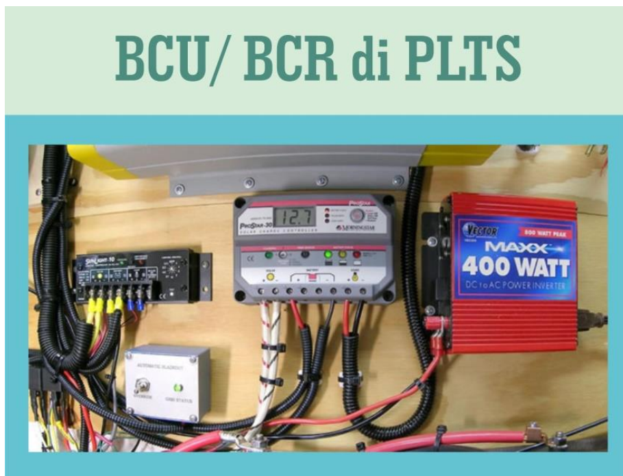
Gambar 38. BCU pada Instalasi PLTS
