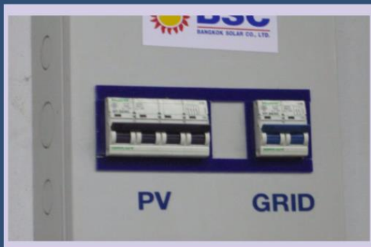
i. Tanda untuk Disconnecting Switch sekalius Proteksi pada PLTS Grid Connected
