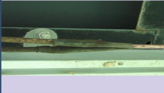
a. Penghantar Indoor digunakan untuk Outdoor
