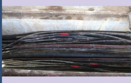
h. Pengawatan pada Konduit di Bawah Tanah
