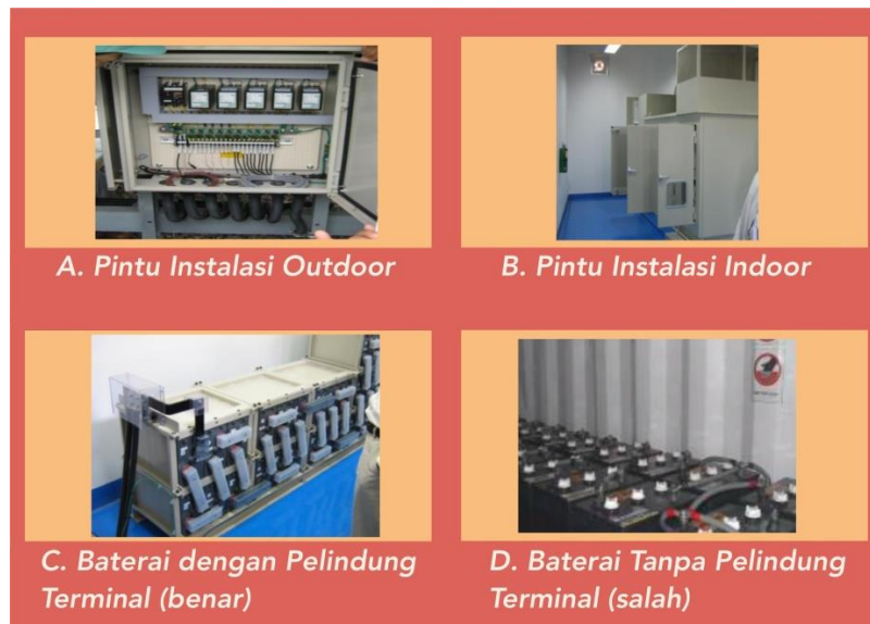
Gambar 40. Inspeksi Perlengkapan Perlindungan Komponen Instalasi
