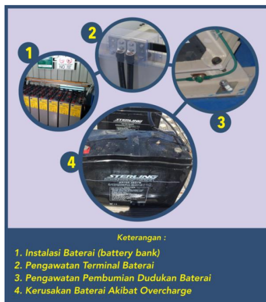
Gambar 36. Battery Bank , Pengawatan, dan Terminal Baterai
