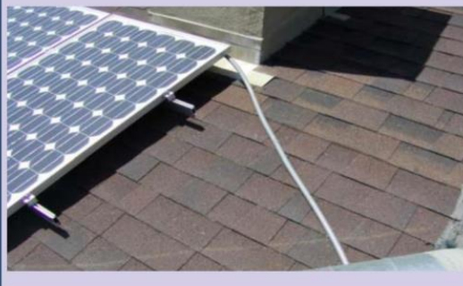
f. Pengawatan PV Array Terhampar Tanpa Pellindung
