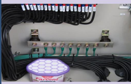
g. Pengawatan pada Junction Box (Pemasangan Terminasi ditandai untuk Pemeriksaan Kekencangan Baut)
