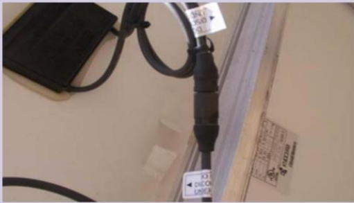
c. Pengawatan antar Modul yang Menggantung
