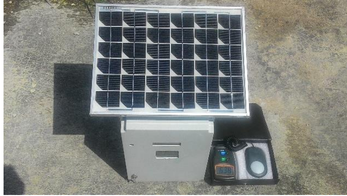
Gambar 40. Persiapan Uji Pengisian Baterai ABH
