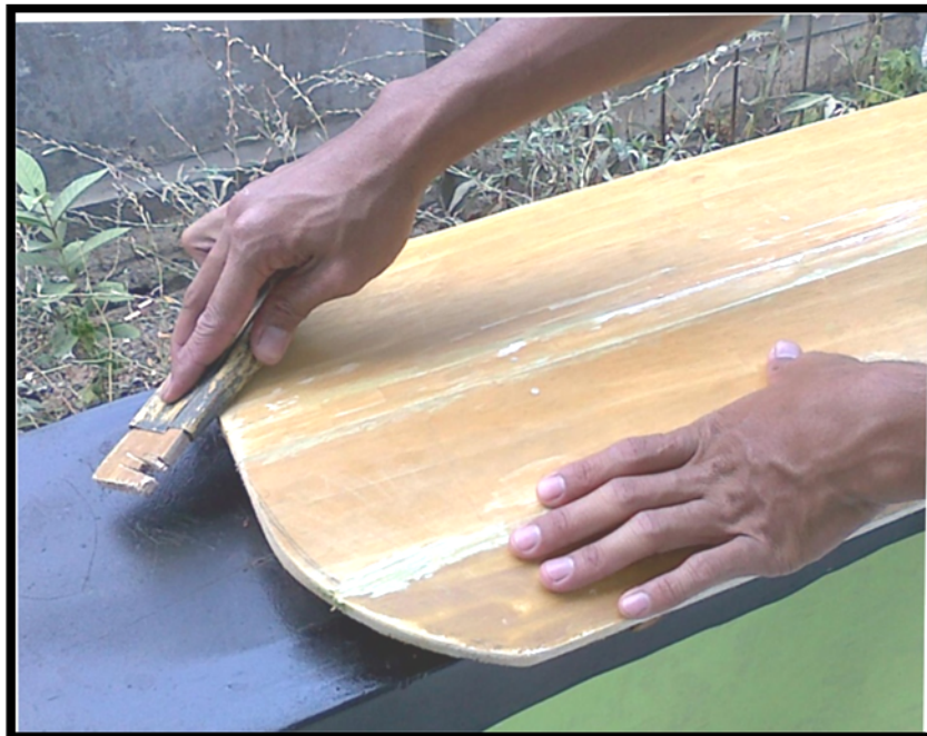
Gambar 20. Proses Merapikan Permukaan Perisai Agar Halus dan Rapi (Dokumentasi Patwanto, 2012)
