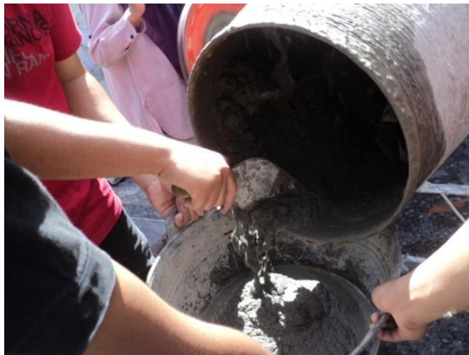
Gambar 44. Pencampuran Material Lapis Kulit
