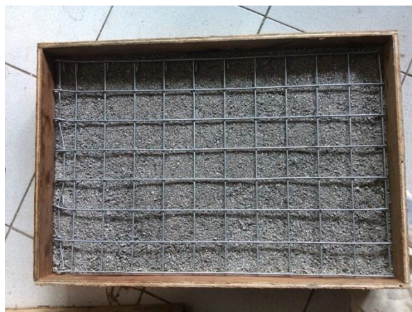
Gambar 1. Peletakan Wiremesh Pada Dinding Styrofoam
