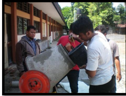
Gambar 45. Memasukkan air
