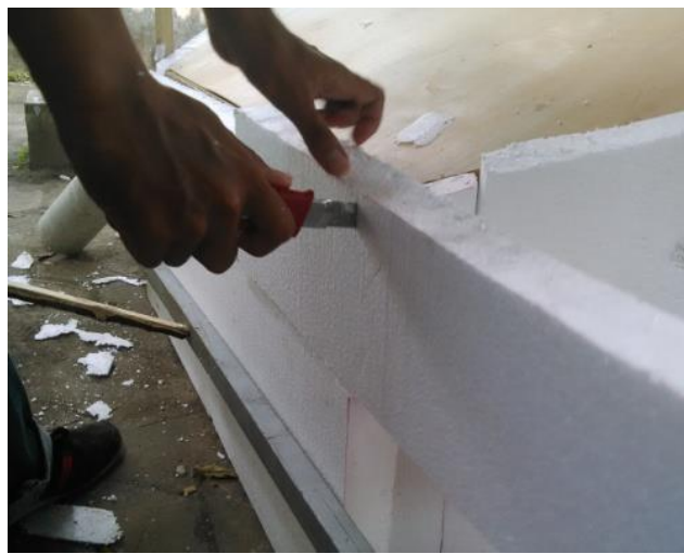
Gambar 22. Gambar Pemasangan Sterofoam
