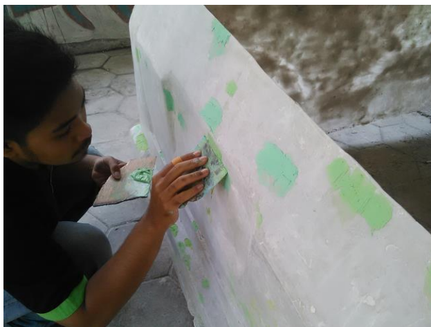
Gambar 26. Proses Pendempulan
