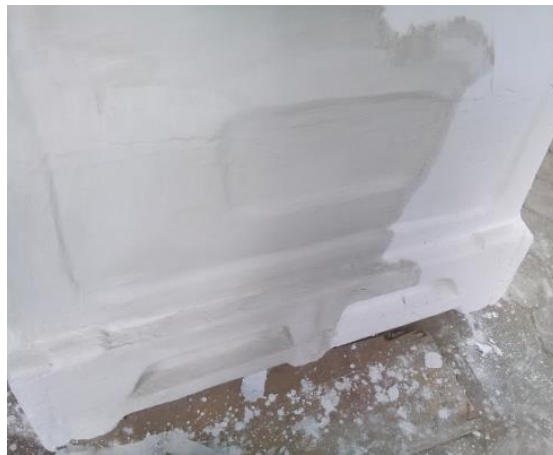
Gambar 23. Melapisi Menggunakan Gypsum
