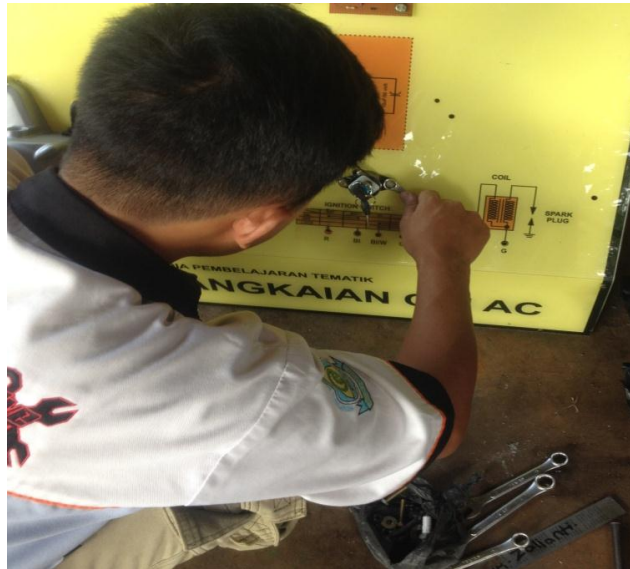
Gambar 69. Pemasangan Kunci Kontak
