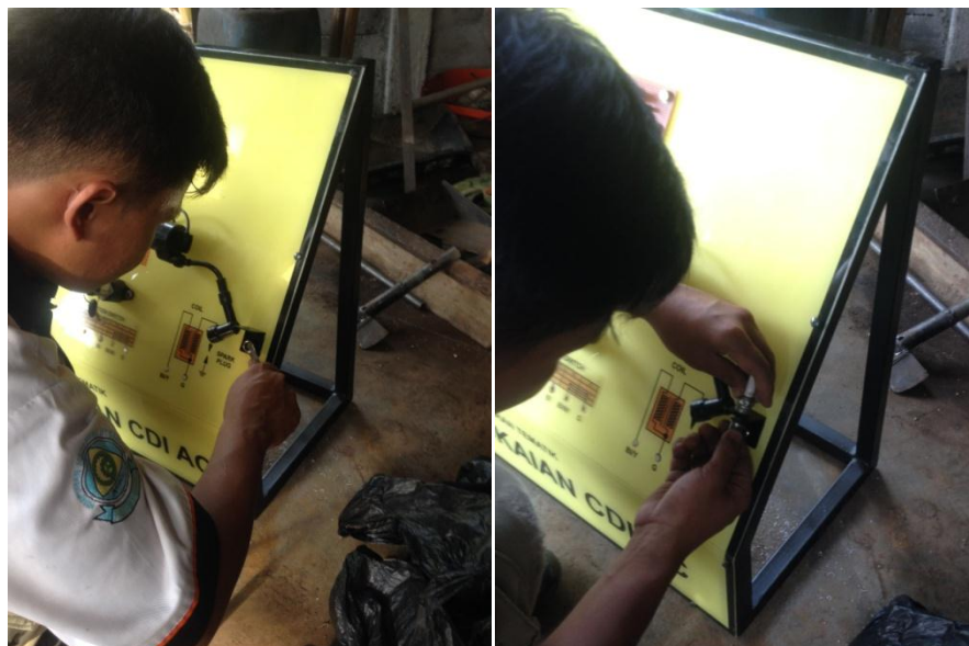
Gambar 72. Pemasangan Dudukan Busi dan Busi
