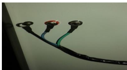
Gambar 38. Memasang Kabel Pada Steker Bust
