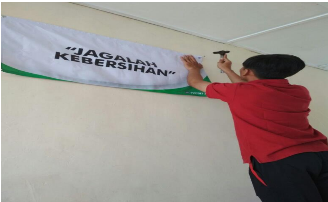
Gambar 6. Pemasangan Banner Himbauan
