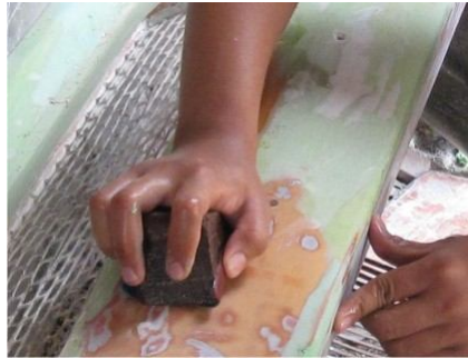
Gambar 26. Mengupas Lapisan Cat
