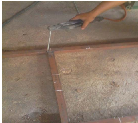
Gambar 22. Perakitan Batang Komponen Dengan Menggunakan Las Listrik
