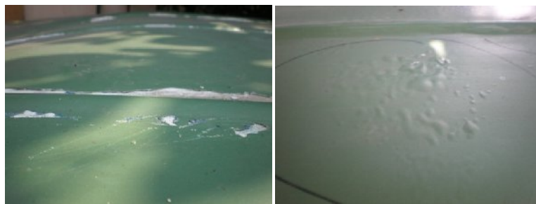
Gambar 29. Kerusakan cat pada bagian atap
