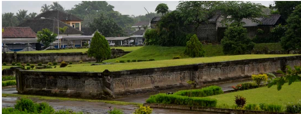
Gambar IV: Fondasi Pendopo Teras Sumber: Dokumentasi Hanifa, Maret 2013
