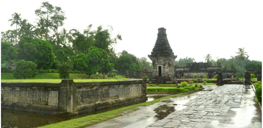
Lokasi Komplek Candi Penataran
