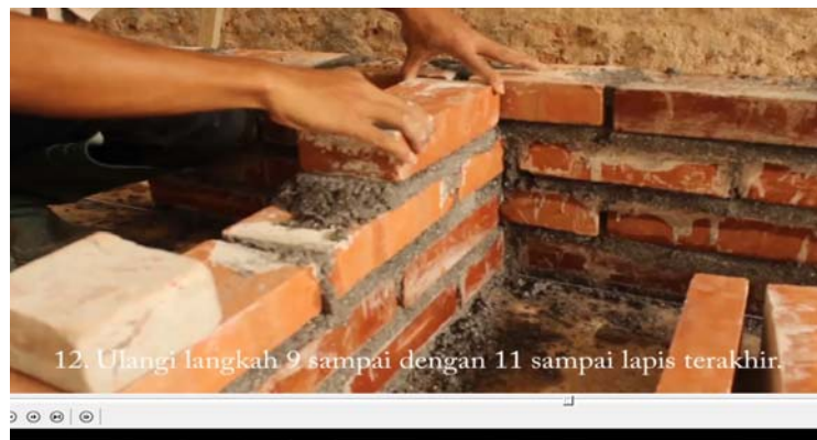
Gambar 50. Langkah kerja 11 pada pekerjaan kedua
