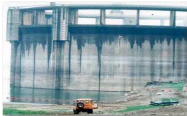
Gambar 3. Pondasi Bendungan http://gustavesp.wordpress.com
