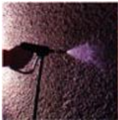
Gambar XI. Bahan akustik yang disemprotkan dengan sprayer gun Sumber: ( http://www.acoustics.com/product_page.asp?prod_id=71 )
