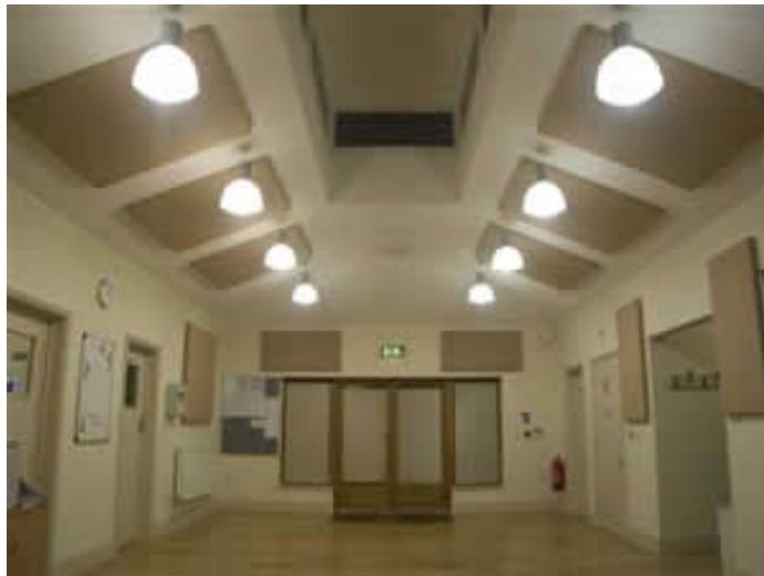
Gambar X. Penerapan Panel Penyerap siap pakai pada plafond Sumber: ( http://herwin.co.uk/images/Great-Abington-absorber-panel.jpg )
