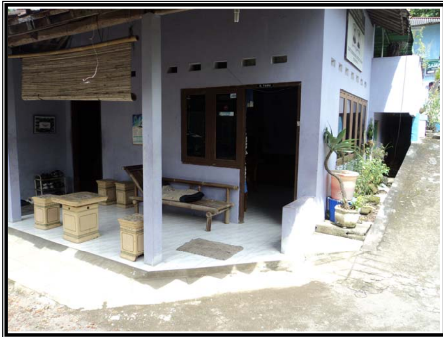
Gambar 2. Gedung Panti Asuhan Bina Amal Shaleh Amanah sebagai Fasilitas Proses Pelayanan terhadap Anak Asuh
