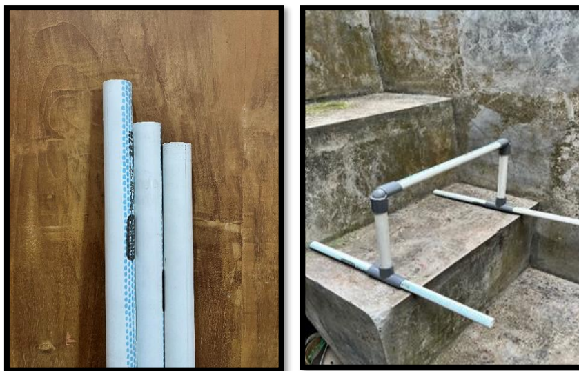
Gambar 8. Pembatas Pipa Paralon (Sumber: Pribadi)
