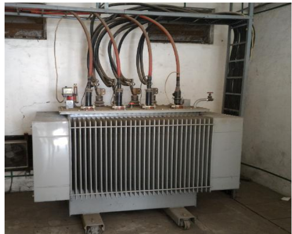
Gambar 5. Fisik Trafo 1600 kVA
