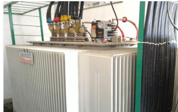
Gambar 5. Fisik Trafo 1600 kVA
