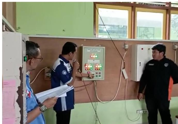
Gambar 5. Demonstrasi Unit ATS-AMF Tiga Fasa
