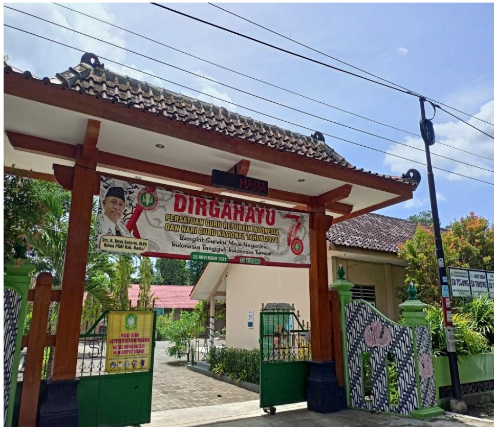
Gambar 15. Tampak Depan SD N Tulung
