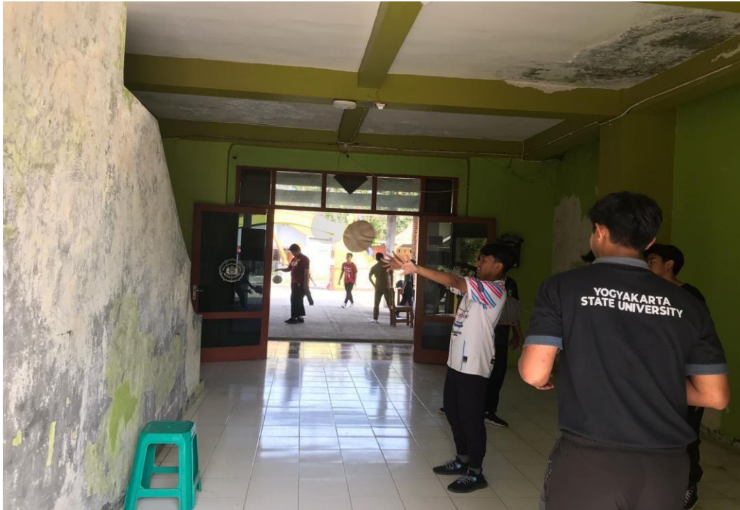
Tes Wall Pass
