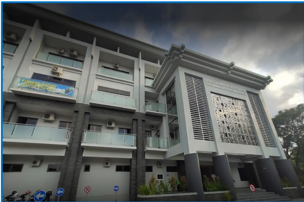
Gambar 1. Lokasi Gedung Fitness Center HSC UNY (Sumber: Dokumentasi Pribadi)
