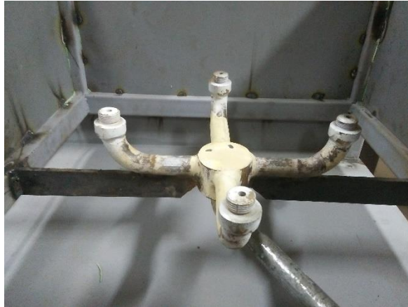
Gambar 4. Pemasangan Nozzle Pada Rangka Oil Filter Cleaner
