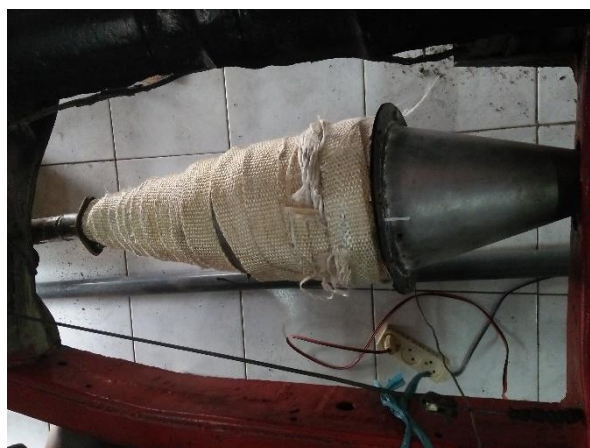
Gambar 3. Memasang Exhaust Wrap Pada DPF Casing
