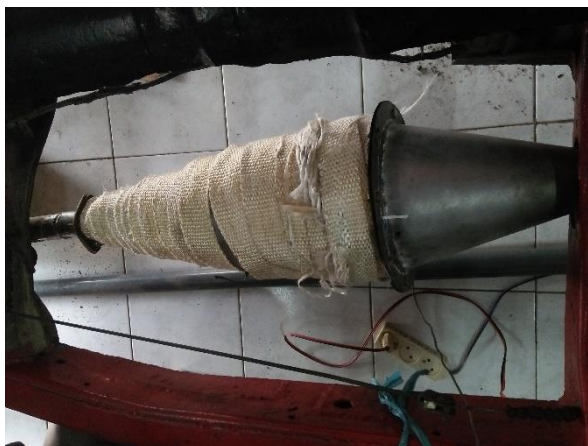
Gambar 3. Memasang Exhaust Wrap Pada DPF Casing
