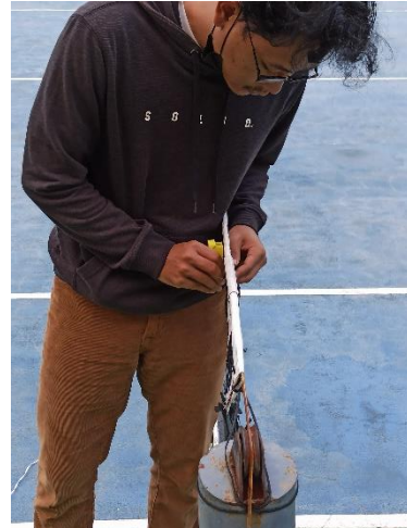
Pemasangan Box sensor
