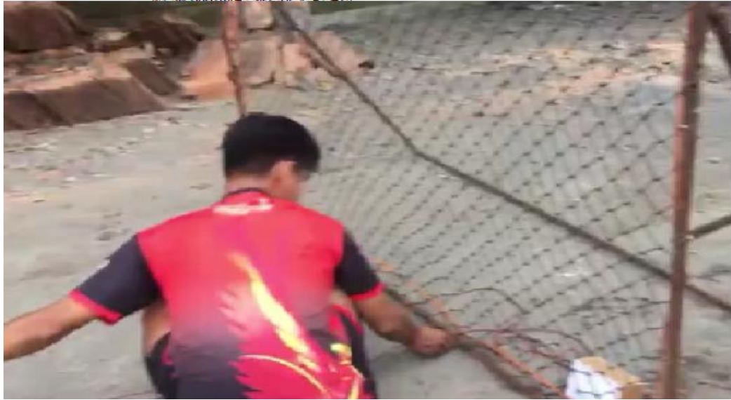
Gambar 12. Mengukur Jarak dengan Menggunakan Kabel.
