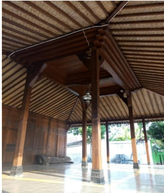
Gambar 23. Saka Guru dan Tumpang Sari Pendhopo Rumah Joglo di Kotagedhe Sumber: Rizqi Allam (2018)
