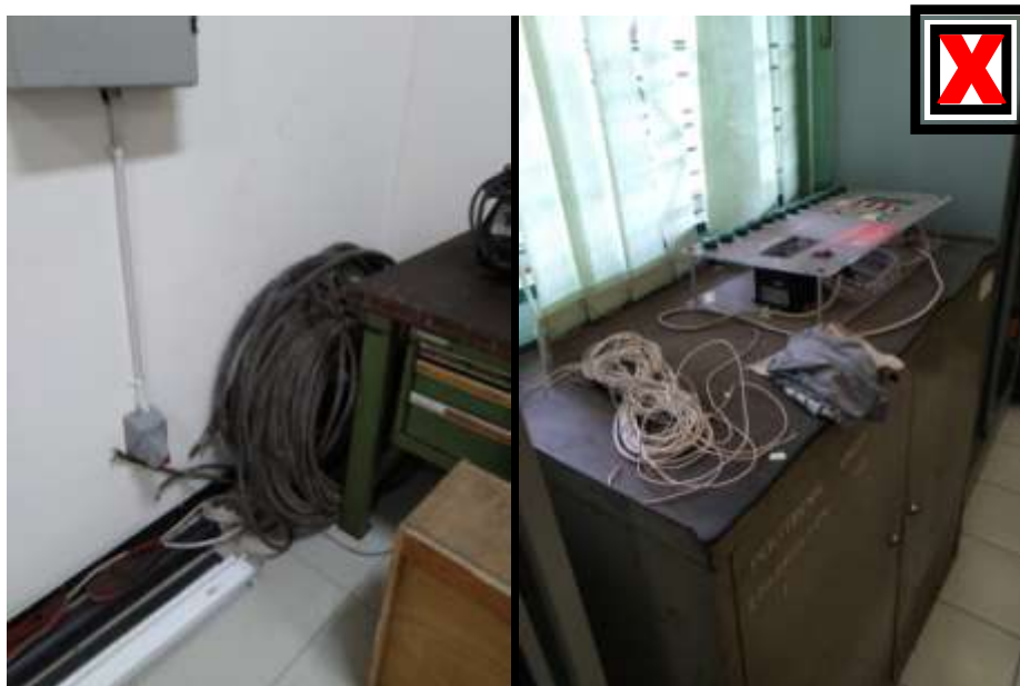
Gambar 37. Kondisi penanganan instalasi kabel di laboratorium Elektro
