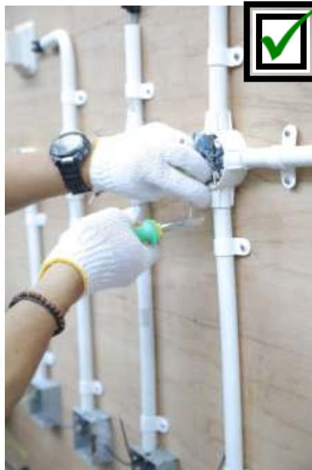
Gambar 51. Instalasi listrik dinding yang aman
