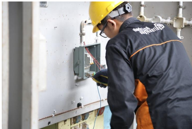
Gambar 52. Pemasangan MCB
