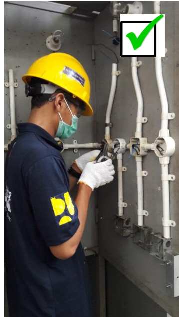
Gambar 27. Instalasi pemasangan kabel
