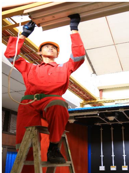
Gambar 35. Penggunaan tangga untuk reparasi
