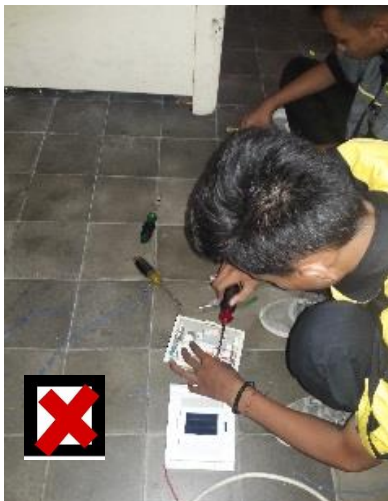
Gambar 19. Pemasangan box MCB
