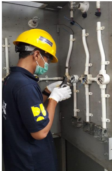
Gambar 37. Instalasi mengenakan APD
