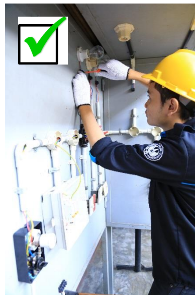
Gambar 2. APD Pemasangan T-dos
