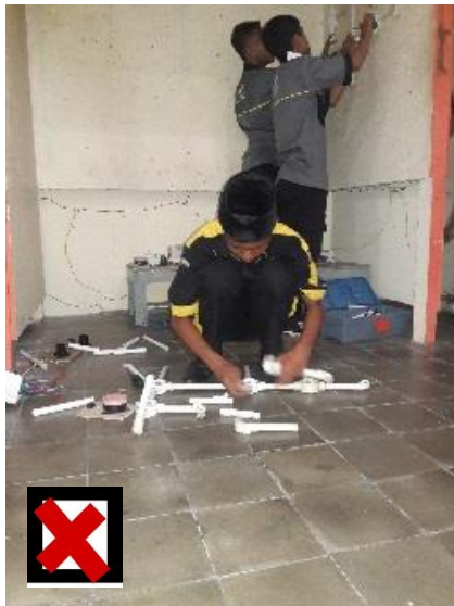
Gambar 10. Merangkai pipa dengan jungkok
