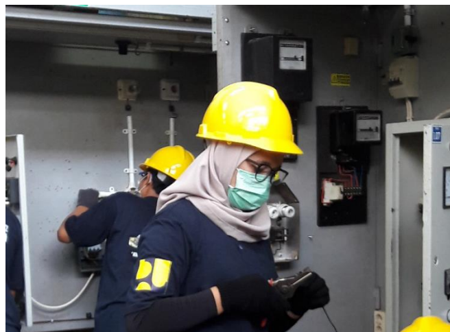
Gambar 45. Mengupas kabel
