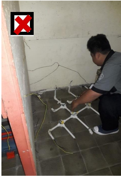
Gambar 26. Merangkai pipa dan memasang kabel dilantai
