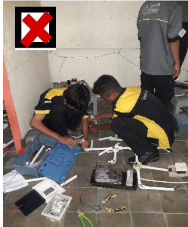
Gambar 24. Merangkai pipa dilantai
