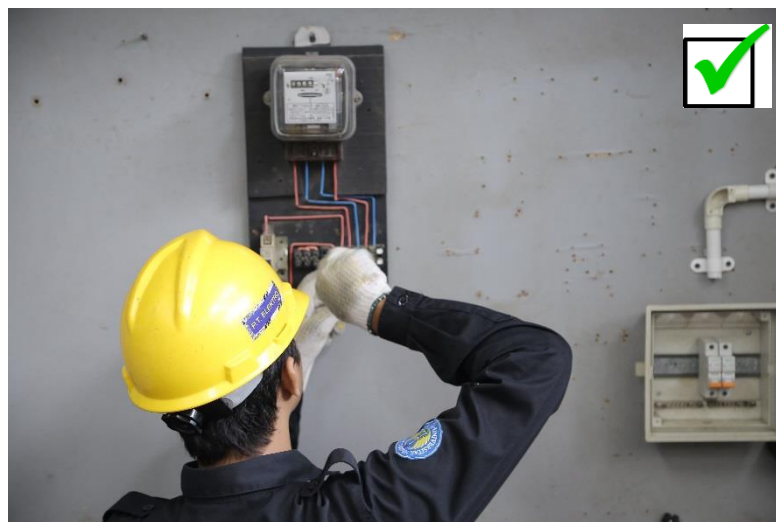
Gambar 28. Instalasi MCB bertegangan
