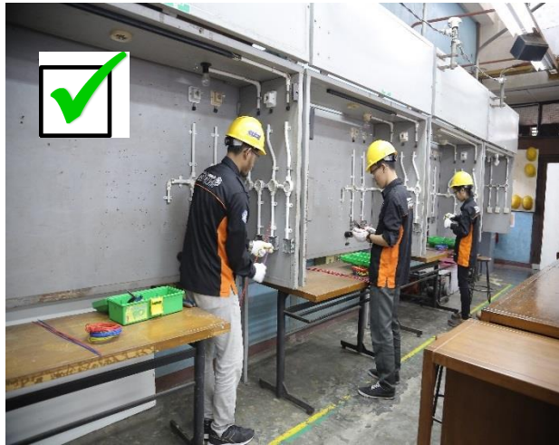
Gambar 9. Praktik instalasi listrik
