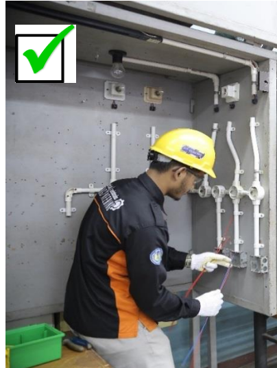
Gambar 25. Instalasi memasukkan kabel
