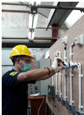
Gambar 33. Contoh memasang pipa di tembok
