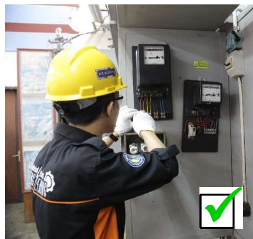
Gambar 18. Pemasangan MCB
