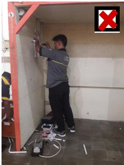
Gambar 1. Pemasangan T-dos
