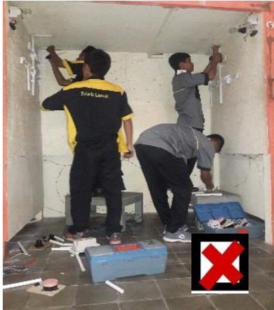
Gambar 8. Instalasi pipa berkelompok
