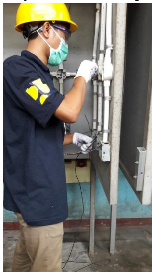
Gambar 50. Praktik memasang kabel
