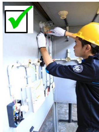
Gambar 5. Memasang pipa dengan safety
