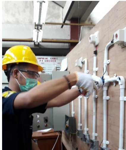
Gambar 54. instalasi pipa pada tembok praktik
