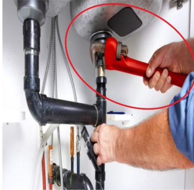
Gambar 49. Ketika tukang membenahi saluran air di wastafel yang mampat atau rusak tukang menggunakan pipe wrench untuk memutar baut
