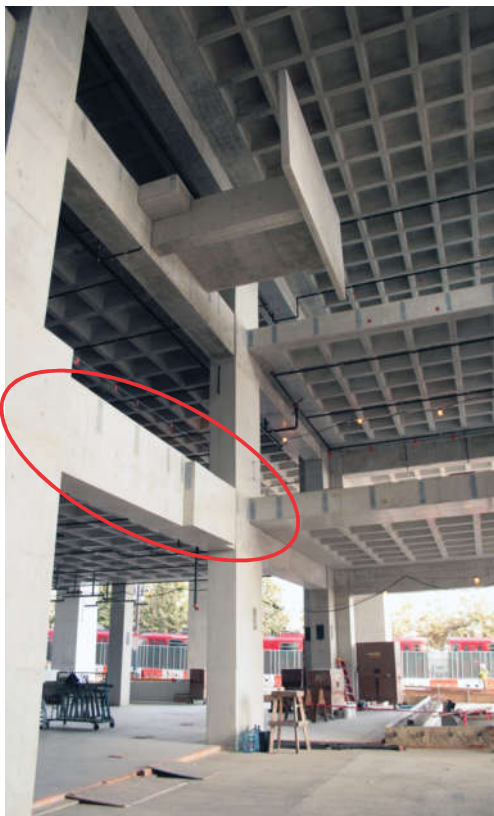
Gambar 56. Struktur bangunan yang terdiri dari plat lantai, kolom dan balok
