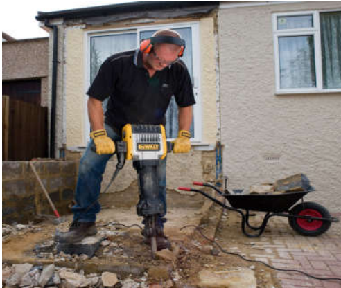
Gambar 3. Pekerja konstruksi menghancurkan batu dengan jack hammer
