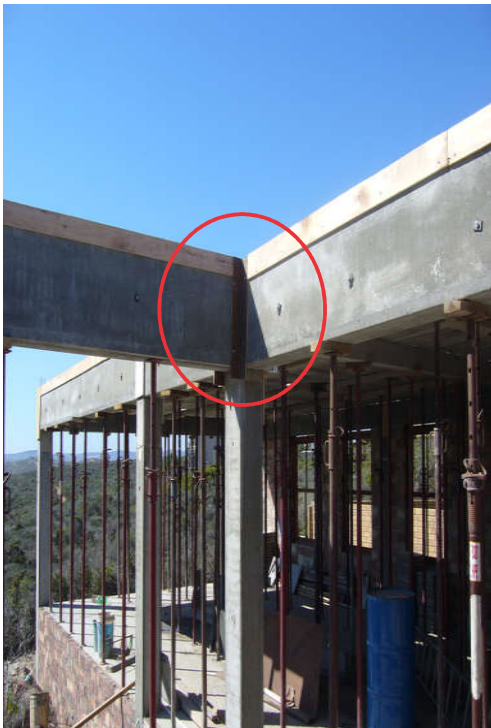
Gambar 54. Tumpuan jepit pada balok bangunan Sumber: https://static1.squarespace.com
