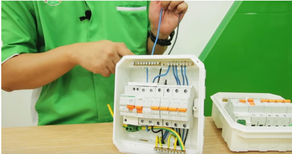
Gambar 18. Instalasi pemasangan SPD
