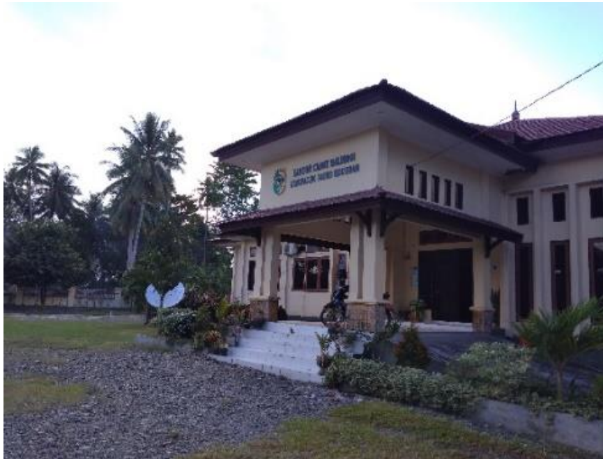
Gambar 3. Kantor Kecamatan Balinggi Tampak Luar (Dokumentasi: Kadek Hariana, 2018)
