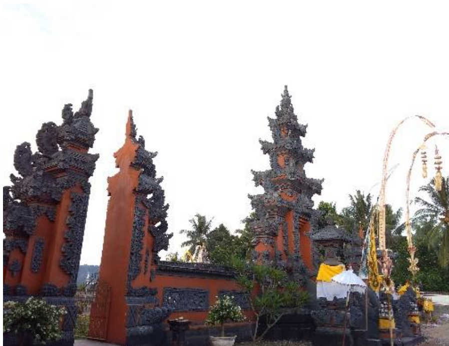
Gambar 4. Bangunan Pura di Jalan Trans Sulawesi Kecamatan Balinggi (Dokumentasi: Kadek Hariana, 2018)
