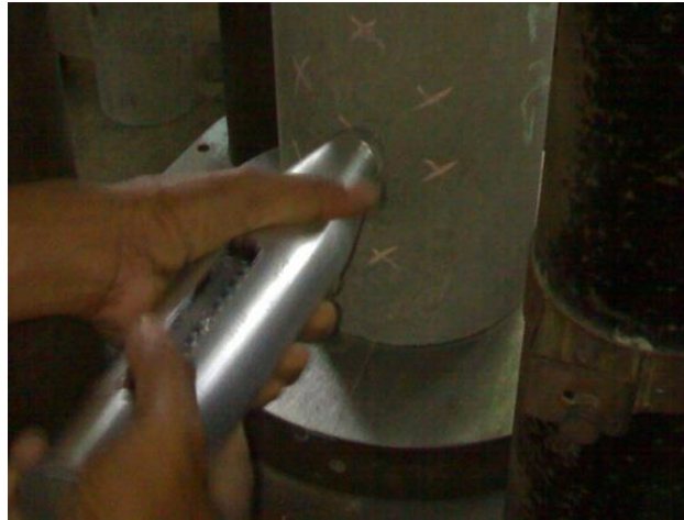
Gambar 31. Pengujian Hammer test
