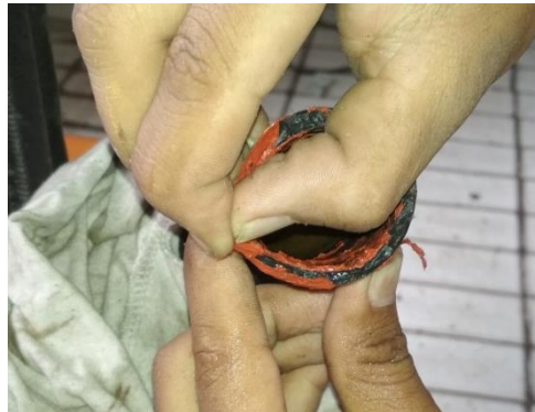
Gambar 10. Pemotongan Selang dan Membersihkan Sealer
