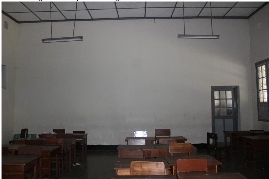
Situasi ruang kelas tampak belakang
