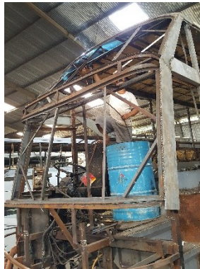
Gambar 49. Pekerjaan Retrofit Rangka Body
