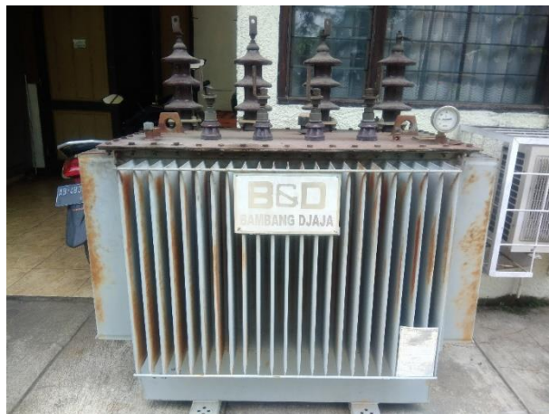
Gambar 12. Transformator 400 kVA
