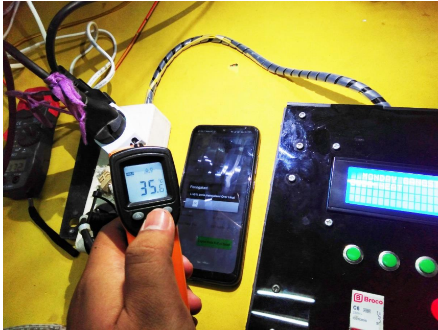
Gambar 41. Kondisi Over Heat Pada Saat Suhu Diatur Dengan Batas 35°C.
