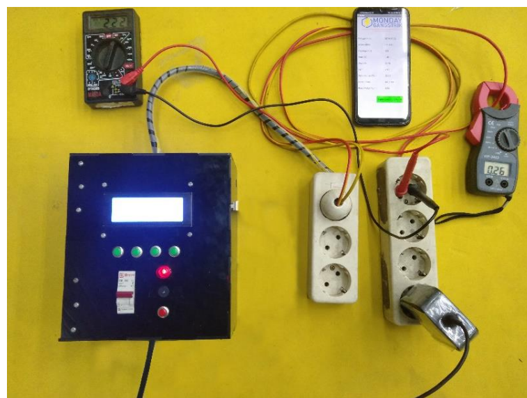
Gambar 31. Pengujian Alat Sebagai Monitoring Daya Listrik
