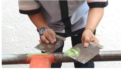
Gambar 9. Proses Pendempulan
