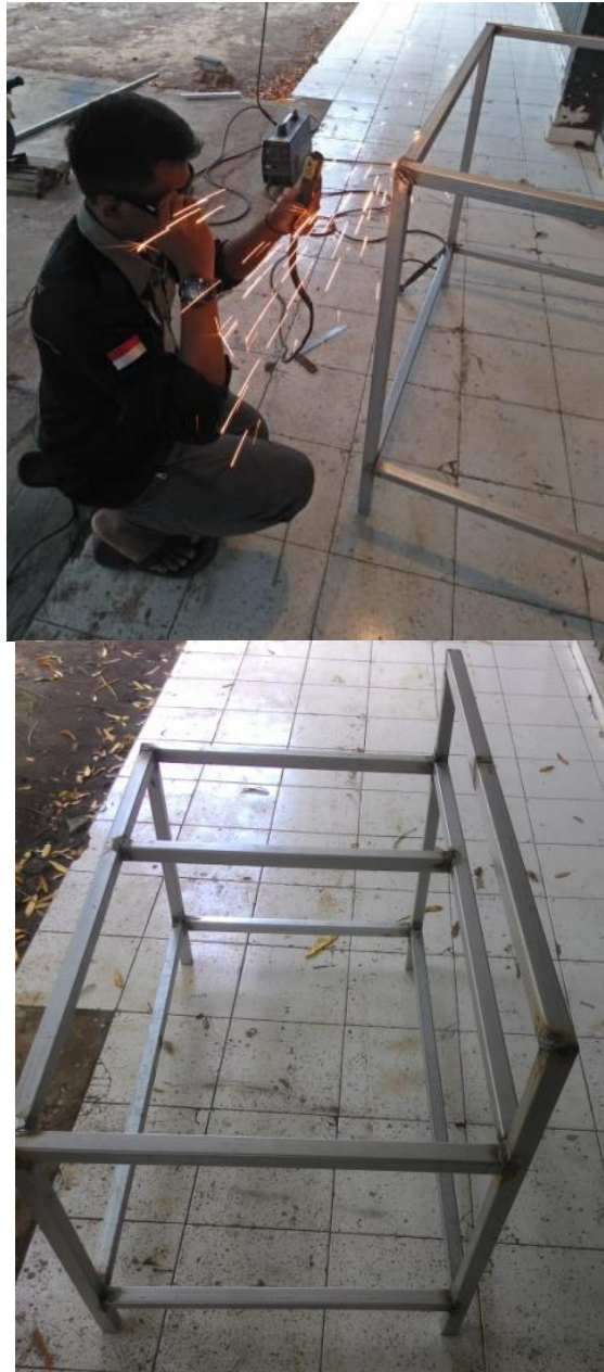
Gambar 40. Proses Pengelasan Kerangka
