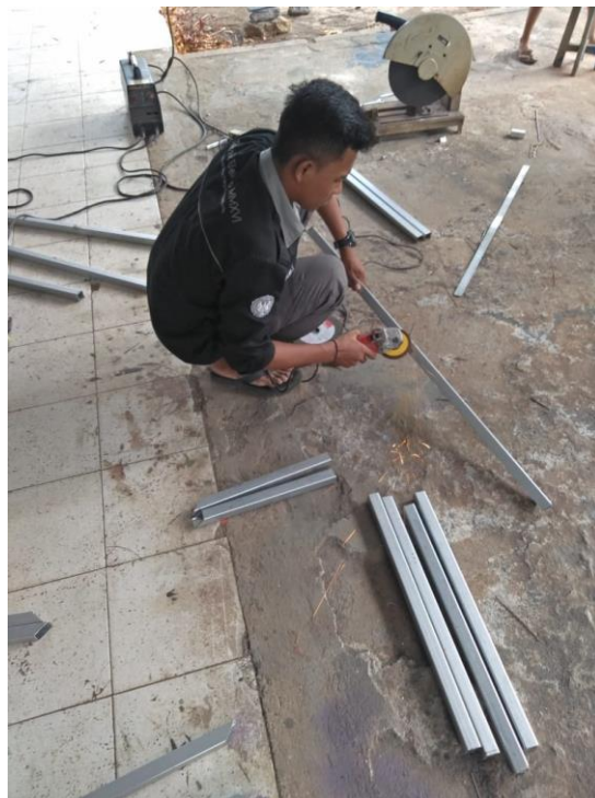
Gambar 39. Proses Pemotongan Besi
