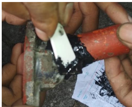
Gambar 14. Merekatkan Pipa Besi Menggunakan Plastic Steel
