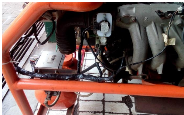
Gambar 14. Pemasangan Jaringan Kabel
