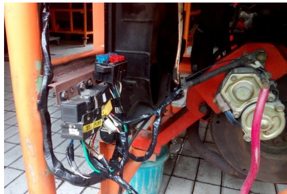
Gambar 13. Membuat Dudukan Fuse Box dan Relay
