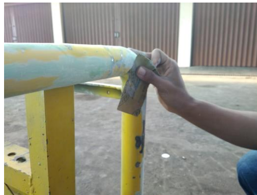
Gambar 8. Proses pengamplasan
