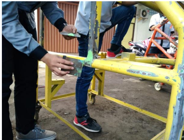
Gambar 9. Proses pendempulan
