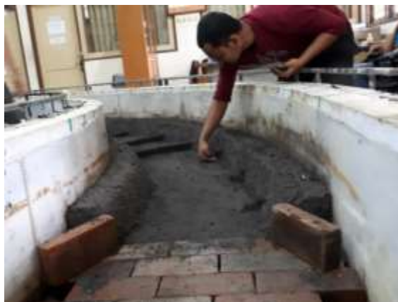
Gambar 66. Pemasangan Perkuatan Pada Belokan
