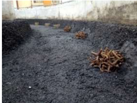
Gambar 31. Pemasangan Tetrapod (Sumber: Dokumentasi Pribadi, 2019)
