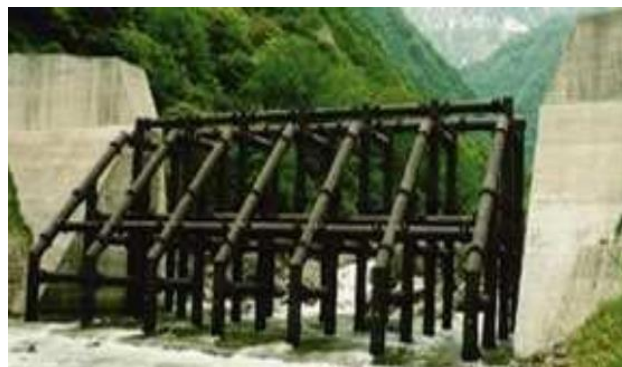
Gambar 7. Check dam tipe grid (Sumber: Nainggolan, 2016)
