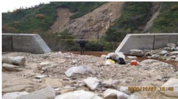
Gambar 7. Check dam tipe terbuka (Sumber: Nainggolan, 2016)
