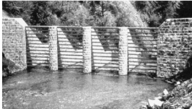
Gambar 8. Check dam tipe beam (Sumber: Nainggolan, 2016)
