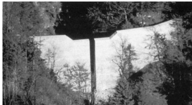
Gambar 6. Check dam tipe split (Sumber: Nainggolan, 2016)
