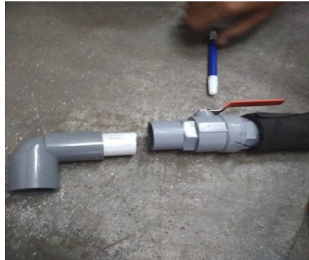
Gambar 11. Pemasangan Pipa Knee
