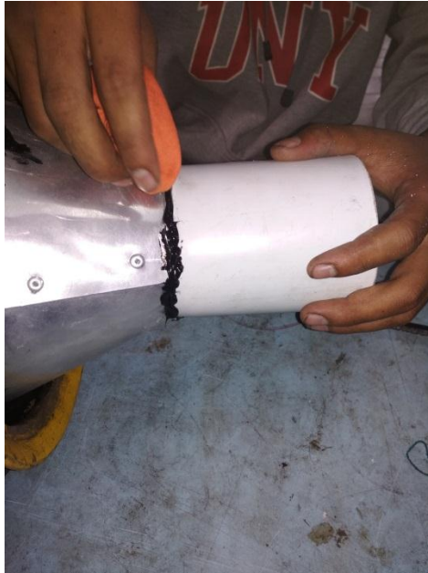
Gambar 10. Penyealeran untuk menutup celah corong
